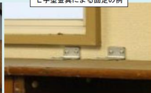
L字型金具による固定の例
