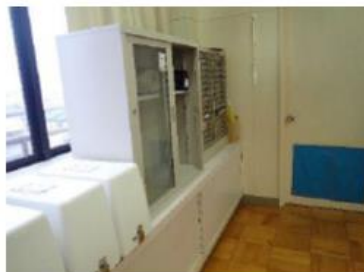
写真2 固定されていない 積み重ねられた棚の例
