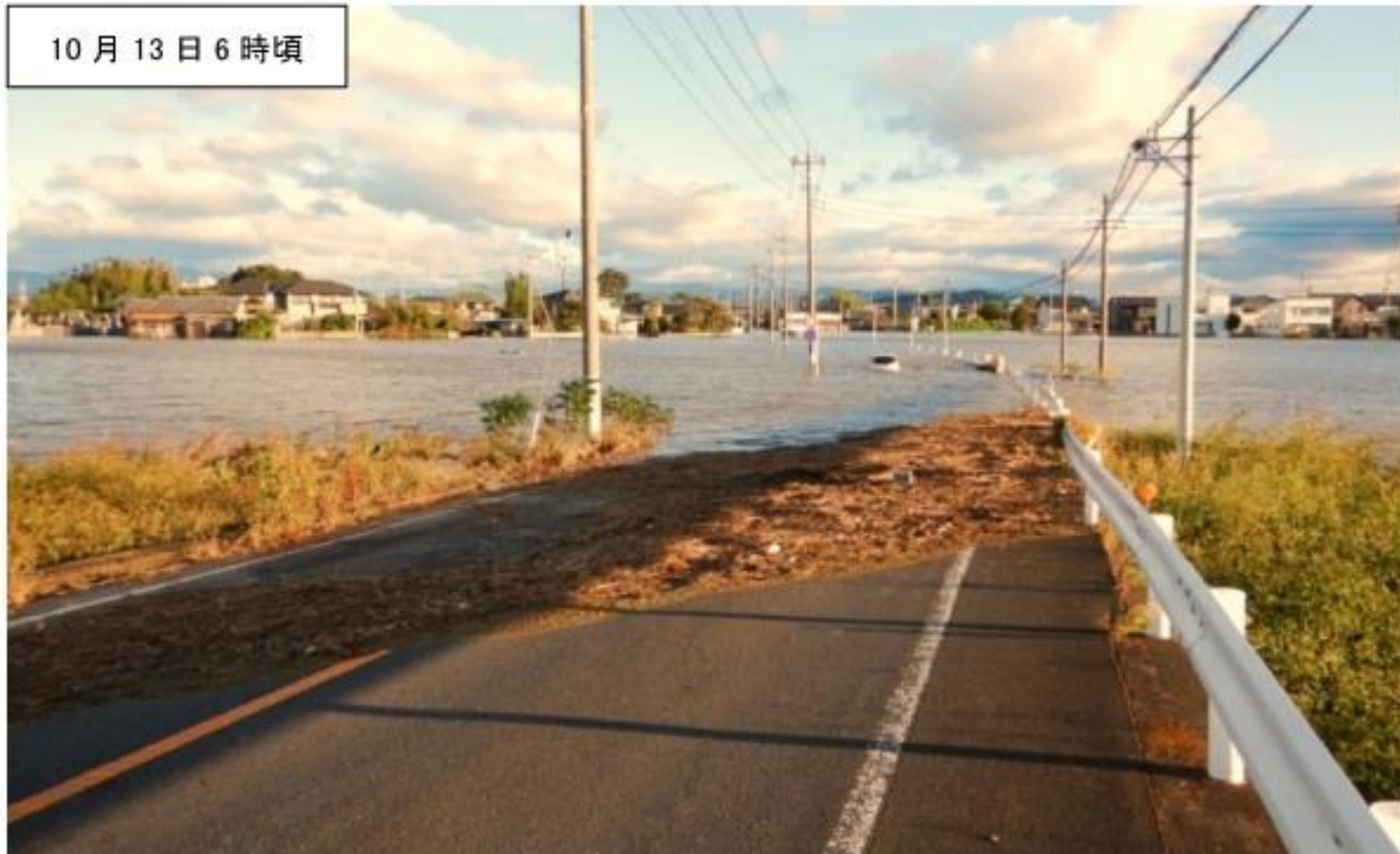
内水氾濫状況(太田市牛沢町)
