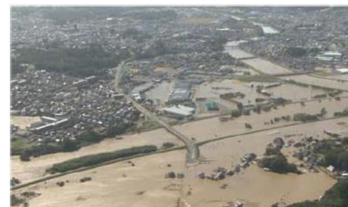
阿武隈川堤防決壊による浸水状況(福島県須賀川市)
