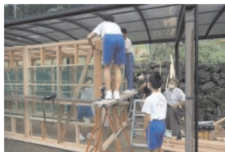
養鶏実習に向けた鶏小屋の建設
