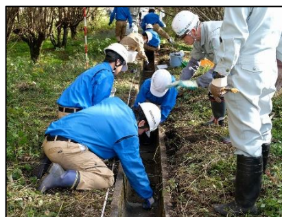
写真2 農業用水路の補修の様子
