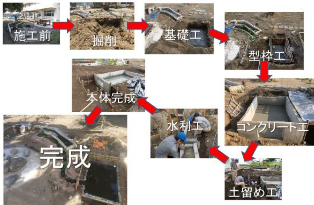
図2 ビオトープ作製の過程（測量、設計、施工等専門科目の学習内容を活用）
