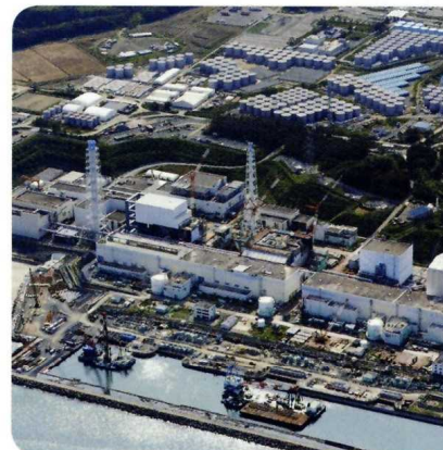
図7 福島第一原子力発電所
