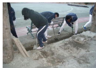
【側溝修復作業】
