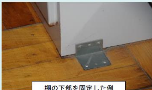
棚の下部を固定した例
