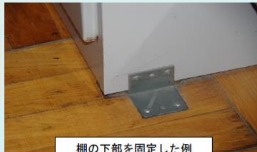
棚の下部を固定した例
