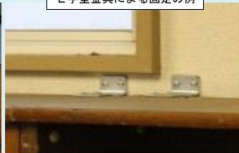
L字型金具による固定の例
