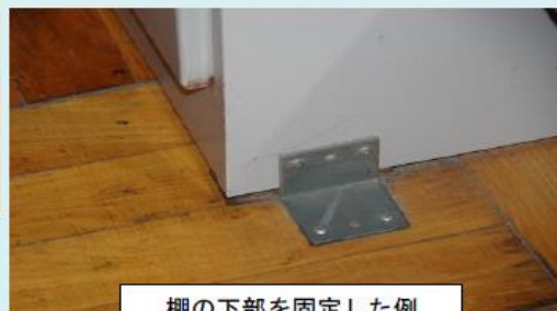
棚の下部を固定した例
