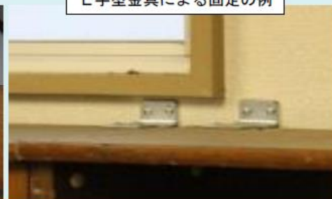
L字型金具による固定の例
